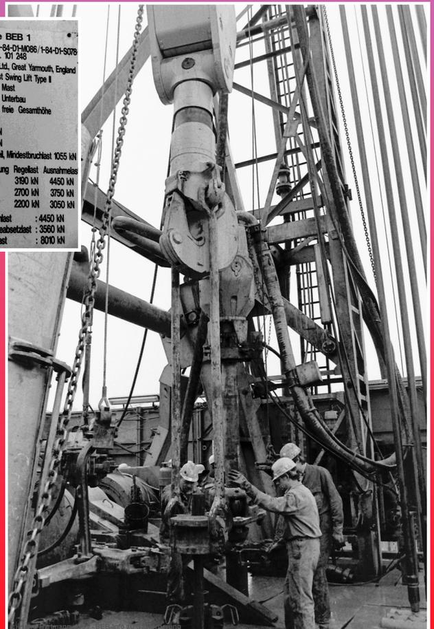
Mehrere Bohrungen nach Erdgas wurden im südlichen Landkreis durchgeführt. Die FF nutzten die Gelegenheit die Anlagen zu befahren, wie es fachlich heißt, um für evtl. Einsätze informiert zu sein. KI Bild oben: Das Eruptionskreuz, die wichtigste Sicherung einer Erdgasbohrung und -förderanlage.
